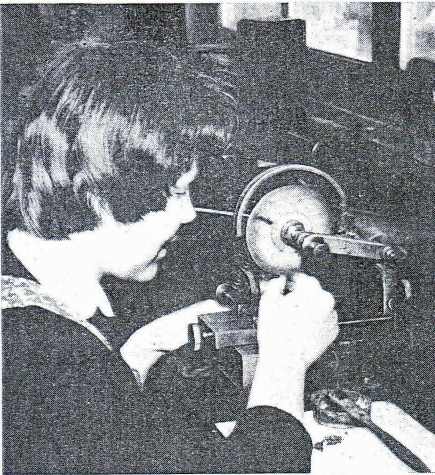
Bild 11: Zahnpoliermaschine für Laufwerkstriebe
