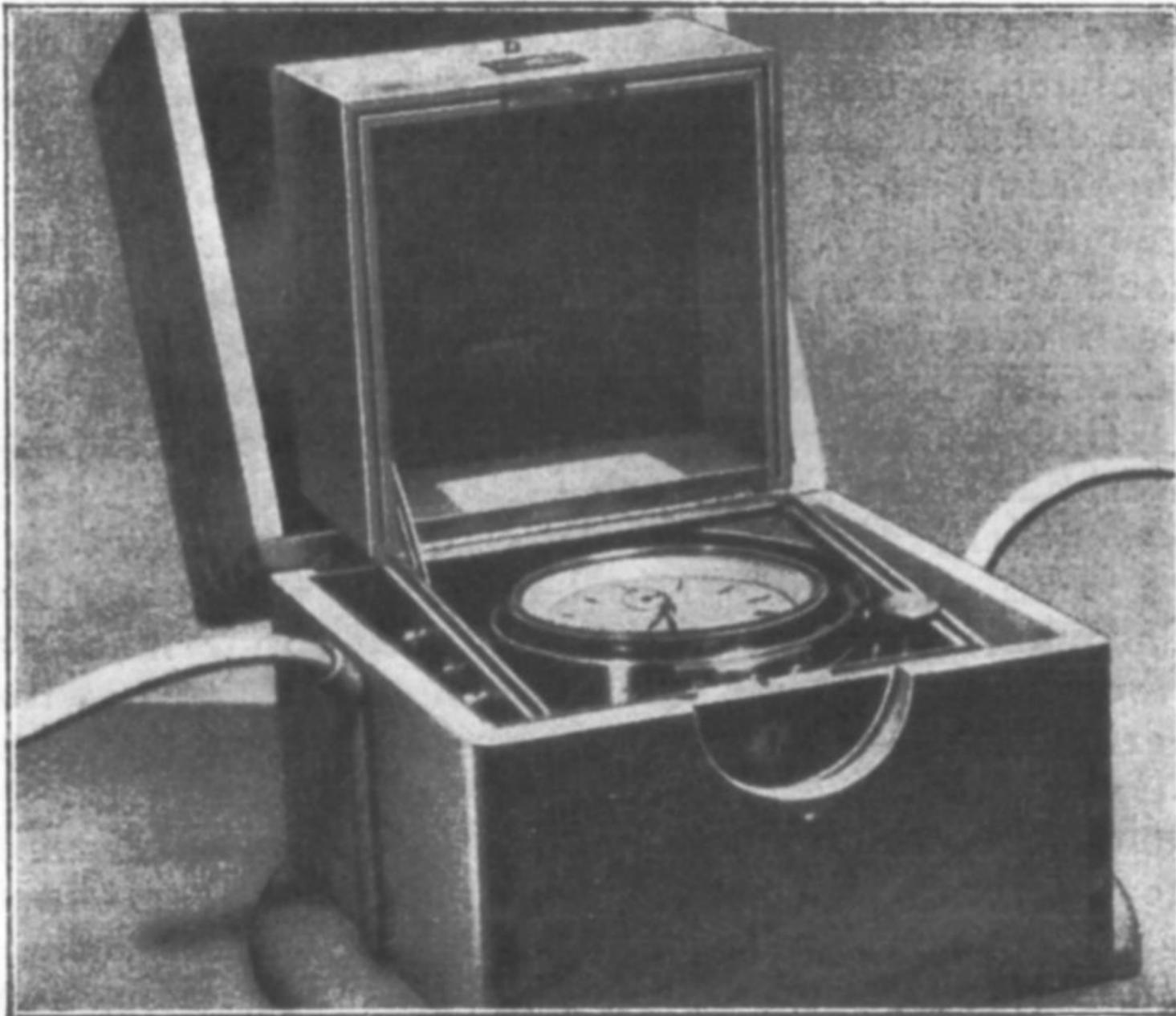
**Der gepolsterte Holzkasten** dient als Schutzgehäuse für den Transport des Chronometers, wenn es nicht an Bord im Gebrauch ist
